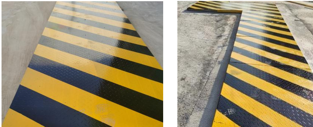
图 6.2.6 定型化后浇带防护盖板
